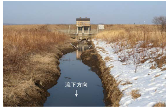
写真-2 対象樋門の概況
