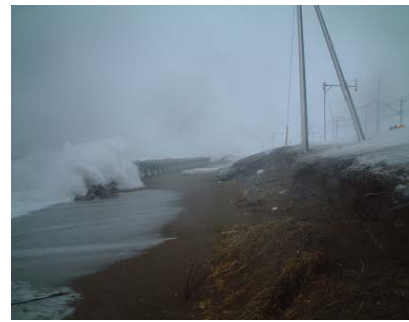
(a) 被災事例 1 (A 地区)
