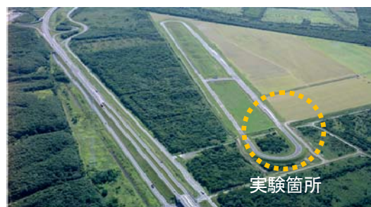
写真-18 苫小牧寒地試験道路
