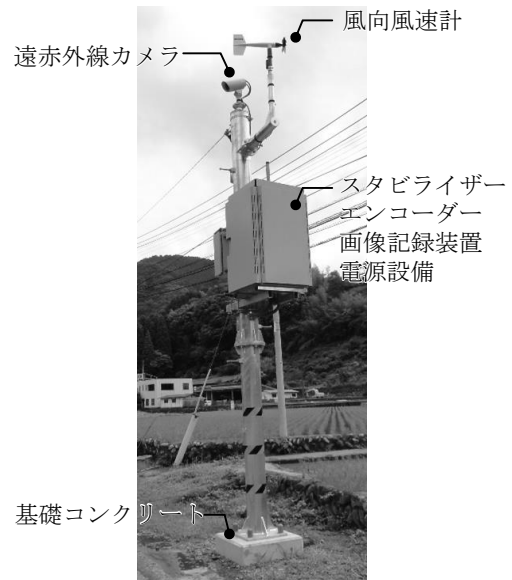
図-20 遠赤外線カメラによる流量観測システム (山国川水系山国川 柿坂観測所)
