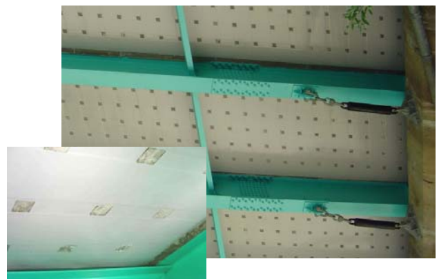
写真-1 格子状 CFRP シート接着による RC 床版の補強事例
