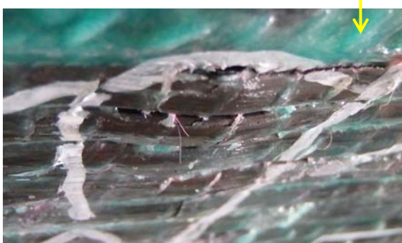
写真-2 CF2のシートのたるみ(図-2中③)
