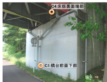
図-4.2 橋梁Aの湿度の観測箇所
