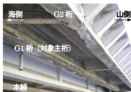
写真-3.1 撤去前の対象橋梁
