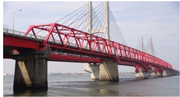
写真-2.2.1 撤去前の対象橋梁(手前)と新橋(奥)
