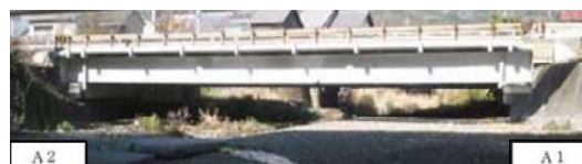
写真-3.5 対象橋梁
