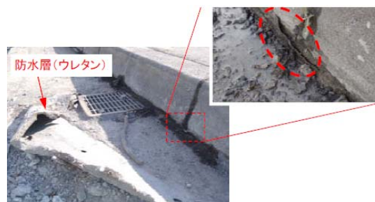
(c) 車歩道境界近傍の防水層の状況
