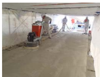
(a) コンクリート表面の研掃の状況
