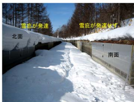
図-72 冬期間の試験施工区間の状況
