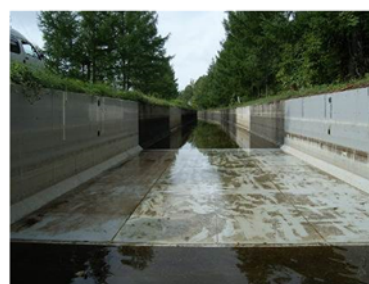
図-67 施工後の状況 (灌漑期間 1 回終了時)
