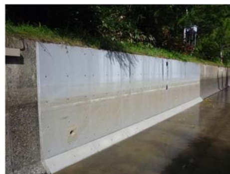
図-73 FRPM板の施工7年後の状況(南面)
