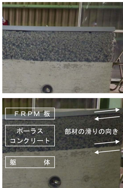
図-109 部材境界面における滑り・開口 (ポーラスコンクリート厚さ t=70mm) (上: 載荷前、下: 載荷後)
