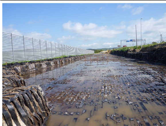
図-25 ジオテキスタイル敷設状況
