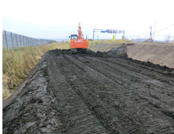
図-26 2次盛土の施工状況
