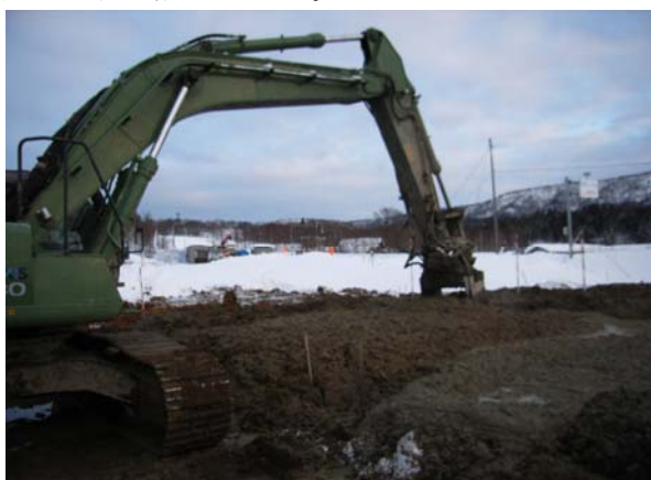
図-19 冬期施工の様子
