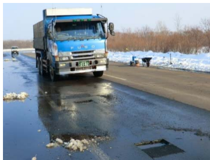
写真-4.2 現場試験状況
