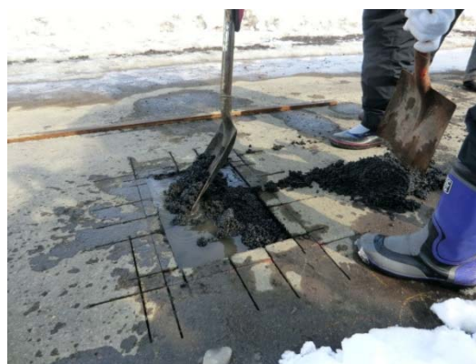
写真-4.1 擬似ポットホールへの常温混合物投入状況
