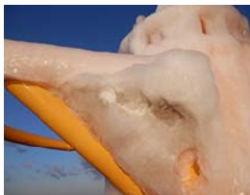
図-4(a) 灯台へ着氷した氷に混入した砂
