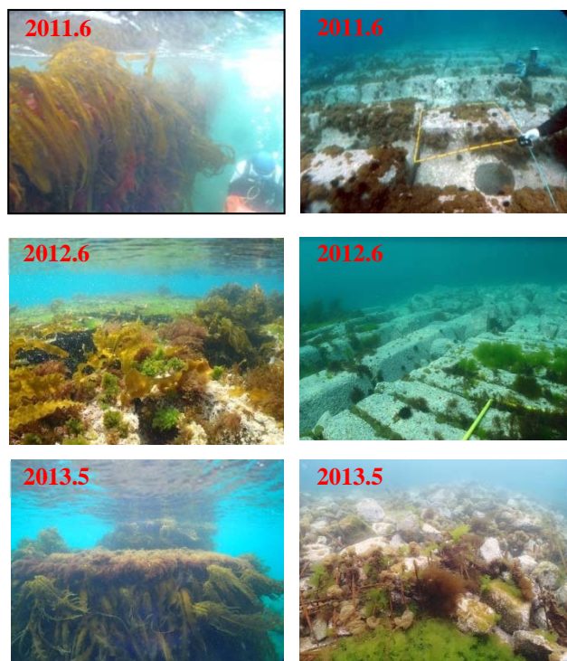
図-11 嵩上げ天端（左）と既設天端（右）の状況
