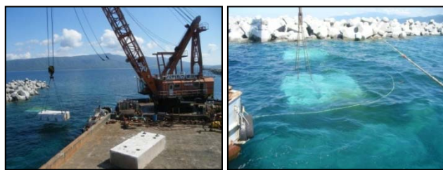
図-6 嵩上げ施工状況
