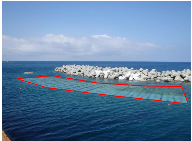
図-19 嵩上げ改良（赤枠部）
