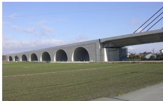
写真-2.1 橋台に近接する連続アーチカルバート
