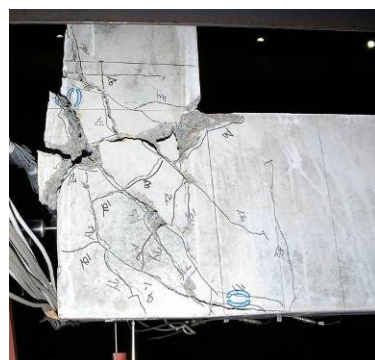
(d) 右側隅角部の損傷 (供試体下面側)
