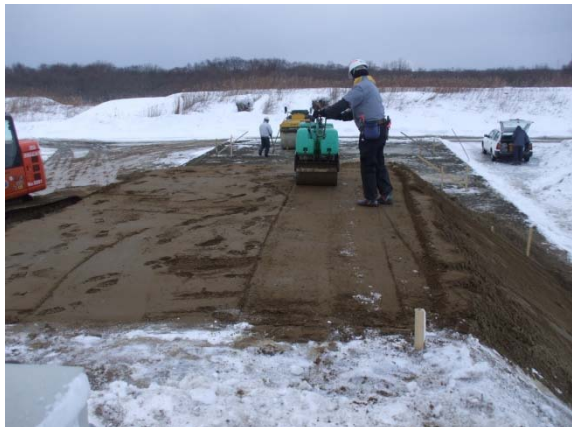
写真-3 試験施工状況
