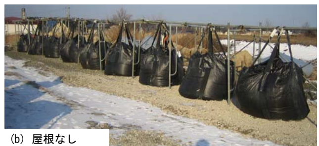
写真-9 大型土のう設置状況
