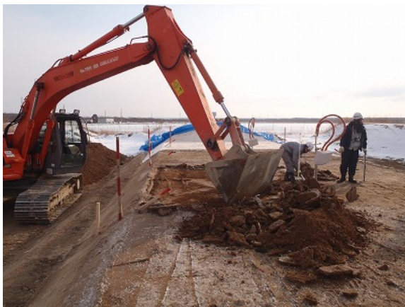
写真-5 凍土除去状況
