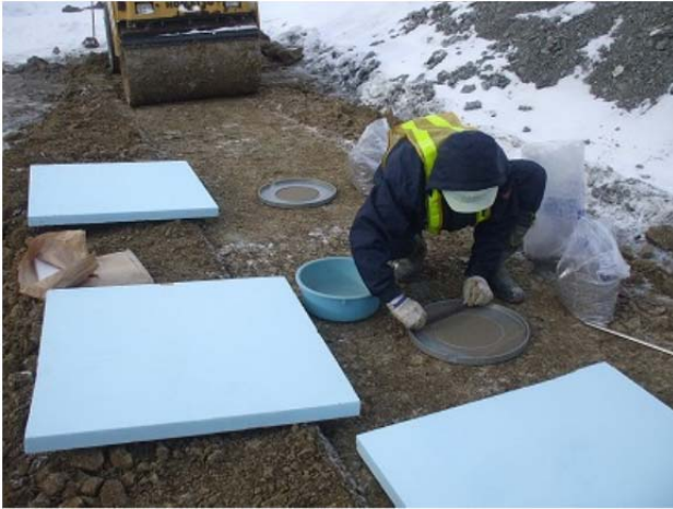
写真-1 砂置換による盛土の密度測定(冬期)
