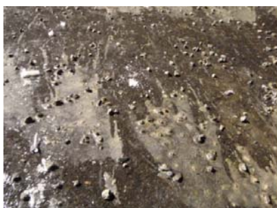
写真 9 防滑材加熱水混合散布後の路面状態
