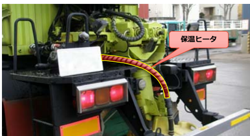
写真 5 保温ヒータ取り付け状況
