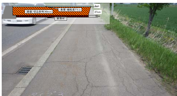
写真-13 断熱材工区 (タイプ3)
