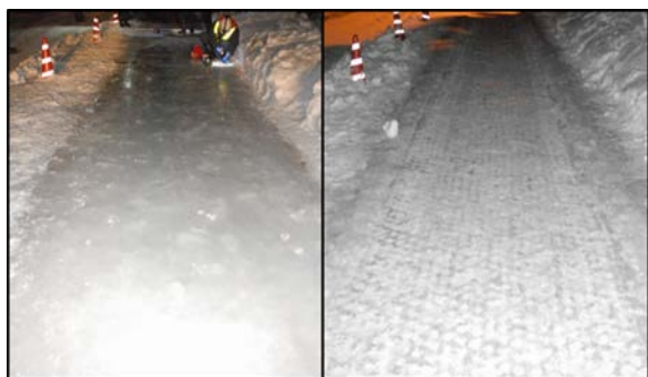
写真-31 雪氷路面の施工前(左)と施工後(右)
