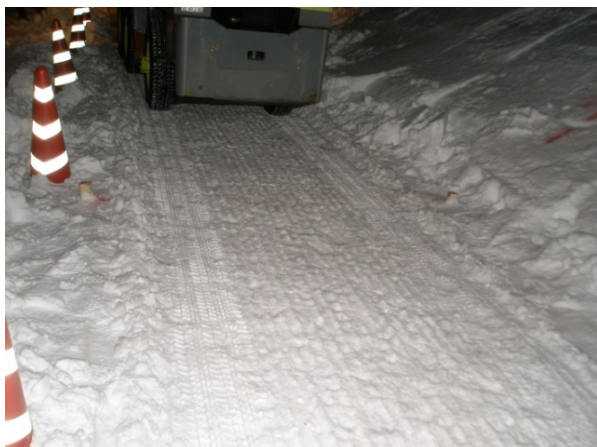
写真-26 改良後の施工状況
