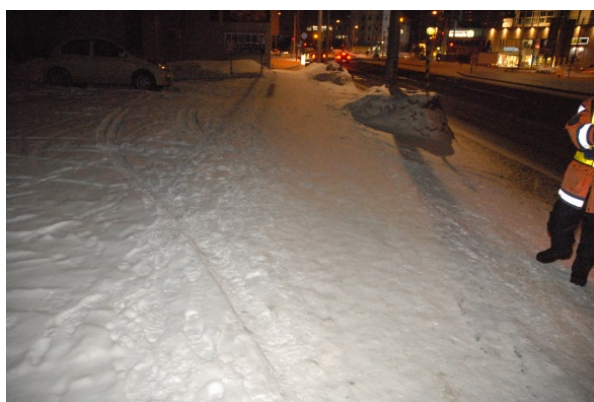
写真-29 現道歩道適応性試験施工箇所
