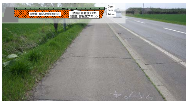
写真-14 舗装厚を増厚する方法 (タイプ4)
