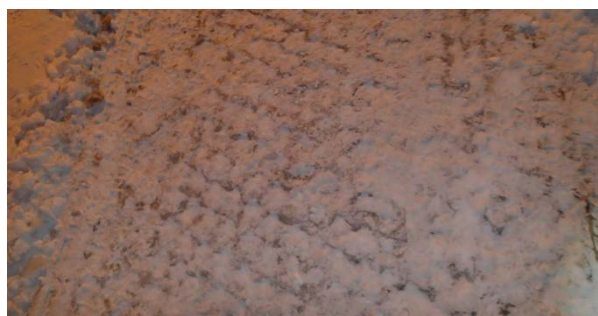
写真-34 雪氷路面処理装置施工後の圧雪路面
