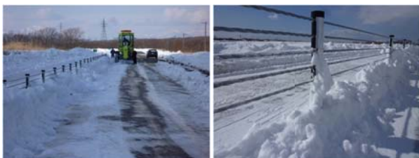
写真18 除雪試験(左)と除雪作業後の堆雪状況(右)
