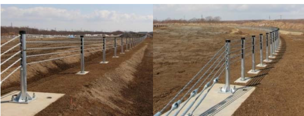
写真19 試験施工(左:サグ区間、右:曲線区間)
