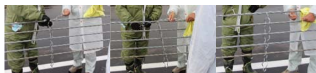
写真10 連結材の取り付け
