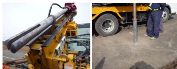
写真 17 打ち込み治具装着 (左) と打ち込み状況 (右)
