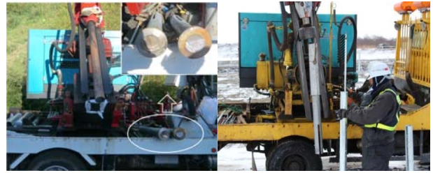
写真20 折損した打ち込み治具と改良した打ち込み治具
