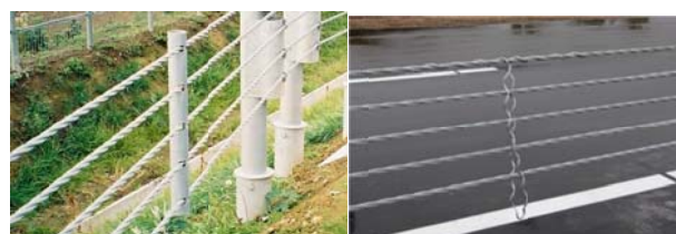
写真9 間隔保持材 (左) と連結材 (右)
