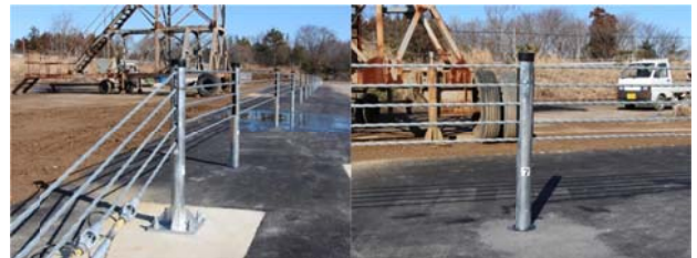
写真 6 防護柵設置状況
