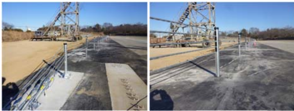
写真2 防護柵設置状況
