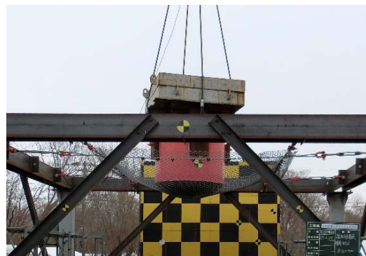
写真-4.1 静的載荷実験状況
