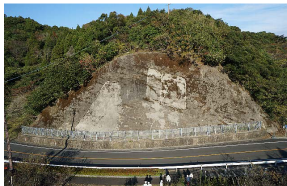
写真6 フィールド調査箇所全景
