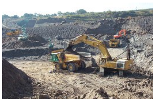
図-2 無人化施工（土工）
