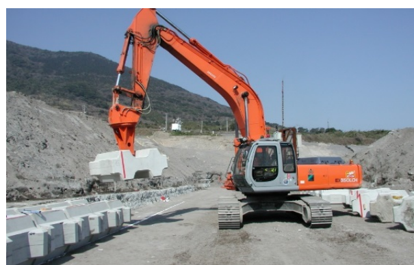
図-3 無人化施工（ブロック調査）
