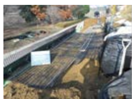
(e) 壁面材及び植生シート設置
