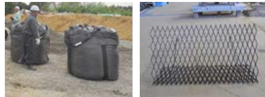
(a) 耐候性大型土のう及び壁面材
