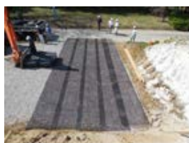
(a) 補強材敷設
