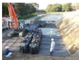
(b) 大型土のう設置
