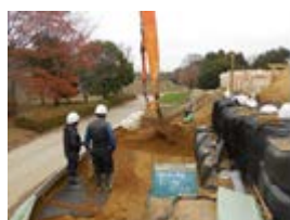
(f) 裏込め材敷均し
