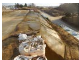
(g) 腹付部上載盛土構築・本復旧盛土完成
