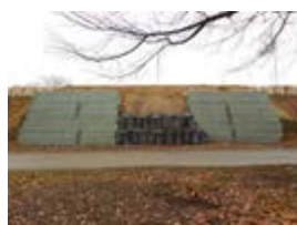
(g) 腹付部上載盛土構築・本復旧盛土完成
