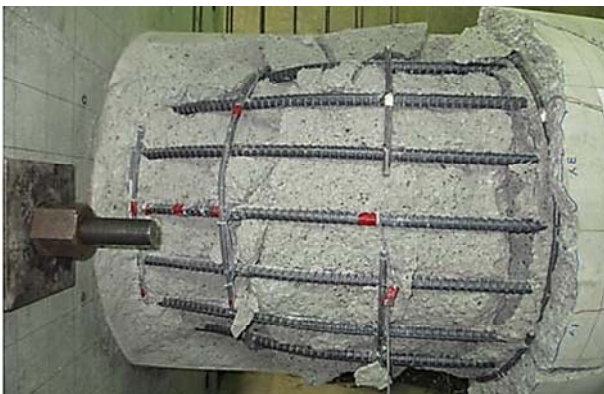
写真-5.4 杭体のせん断破壊状況 (P面)
