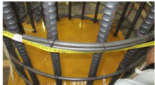
写真-5.1 帯鉄筋の継手方式(重ね継手)
