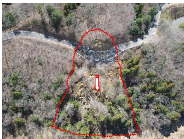
写真-3 Y地区（管轄事務所提供の調査報告書より）
