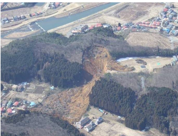
写真-5 H地区(土木研究所HPより)
