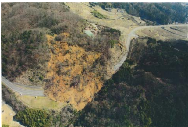
写真-1 K地区（管轄事務所提供の調査報告書より）
