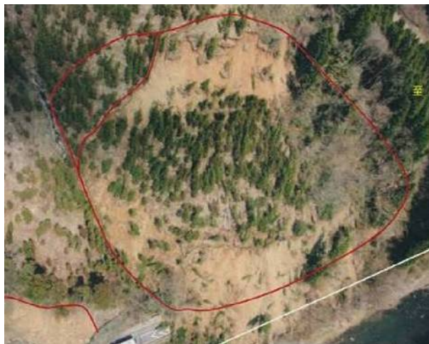
写真-4 S地区(管轄事務所提供の調査報告書より)
