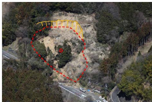
写真-2 O地区（管轄事務所提供の調査報告書より）
