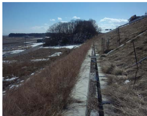
写真-5 盛土のり面および周辺の状況
