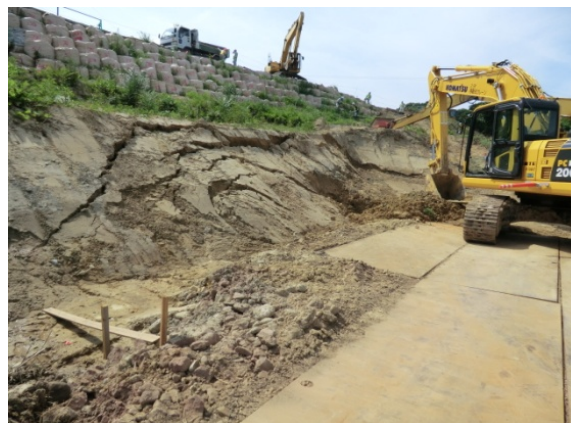
写真-4 復旧中ののり尻部の状況
