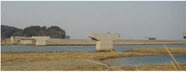
写真-2.1 津波により橋桁が流出した橋梁
