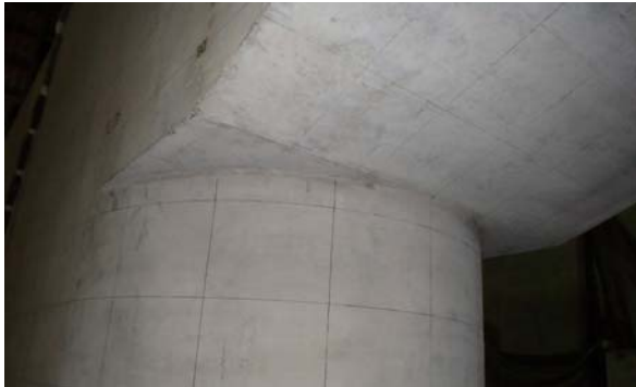
(b) 下端横梁部および柱部 (支承1側)
