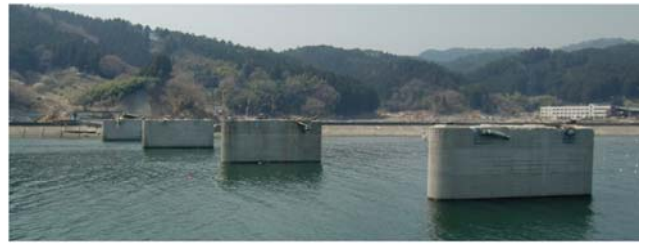
写真-2.1 津波により橋桁が流出した橋梁
