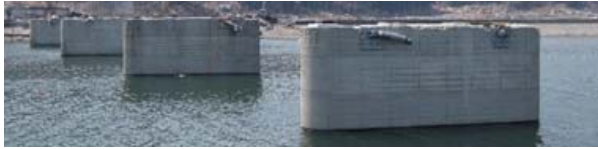
(b) 支承部の破壊により機能損失した橋 写真-11.1 津波による橋の機能損失
