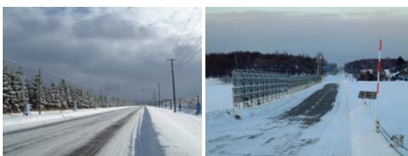
図 2 道路防雪林・防雪柵（吹き払い柵）の設置状況
