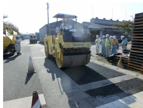
写真-1 試験施工状況
