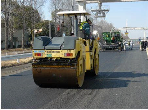
写真-3 締固め状況
