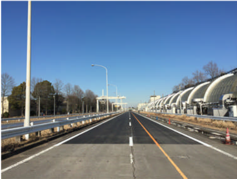
写真-4 施工後概観
