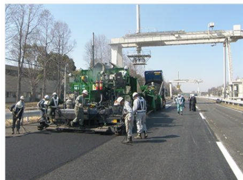
写真-2 舗設状況
