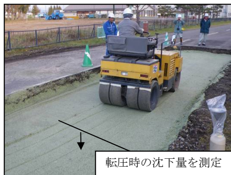
写真-3-1 再生資材工区の転圧状況
