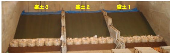
写真-1 盛土構築状況
