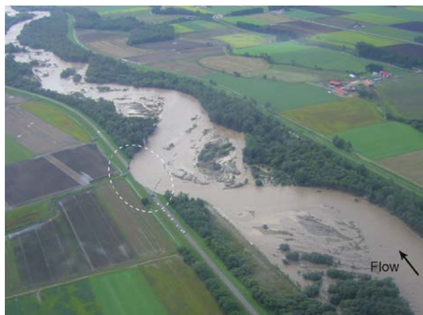
図-3.3 堤防流出状況（9月7日 午前）
