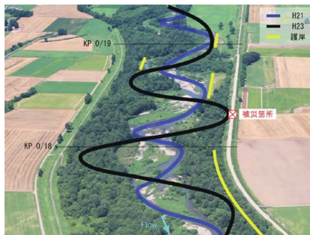
図-3.5 出水前後の流路線形と護岸箇所（撮影 2009. 9）
