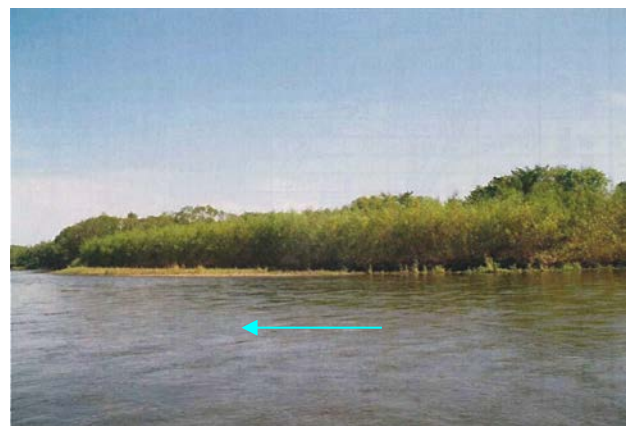
図-2.15 粗朶法覆工の施工後5年の状況
