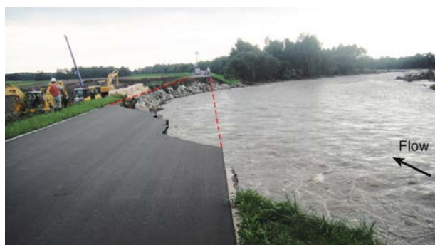
図-3.4 応急対策後の現地状況（9月9日 15:30）
