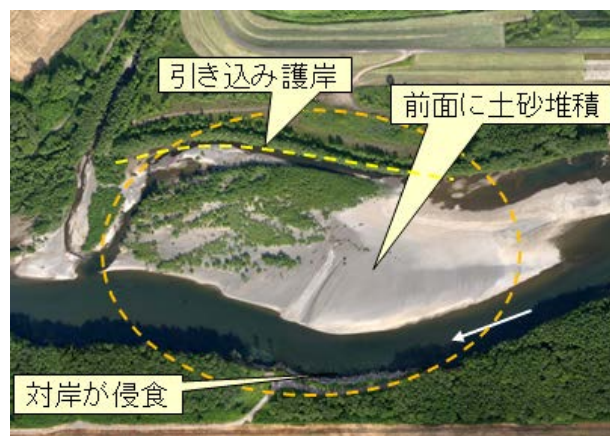
図-2.23 護岸施工後の対岸の侵食状況 (2013年撮影)
