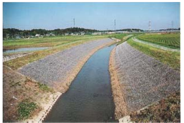
図-2.16 植生が回復しないかごマット護岸 (多自然型川づくりレビュー委員会資料 11) )
