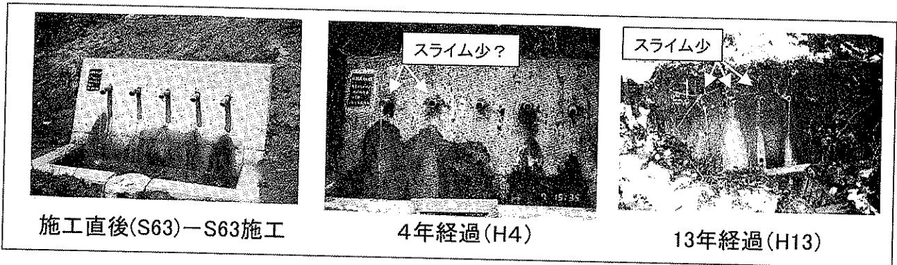
写真-6 スライム付着ありの横ポーリングの経年変化の一例
