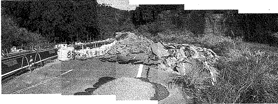
写真-1 道路の復旧例
