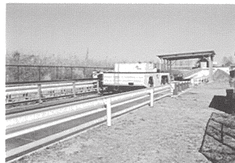
写真-3 リサイクル舗装材料耐久性試験施設
