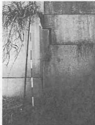
図-4 テールアルメの被害例
