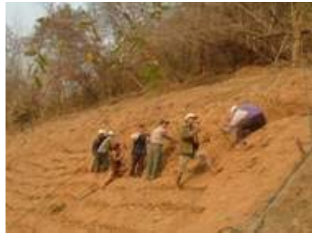
一2 溝切りと混合土のめ
