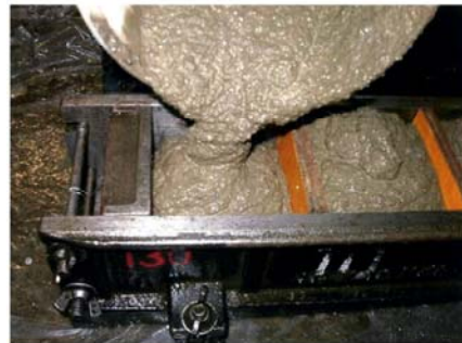
(6) 上半分のモルタル打設
