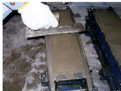
(7) モルタル打設後の均し
