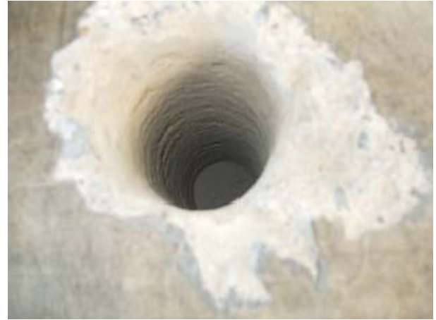
写真-5 ジャックハンマによる削孔後
