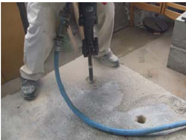
写真-4 ジャックハンマによる削孔状況
