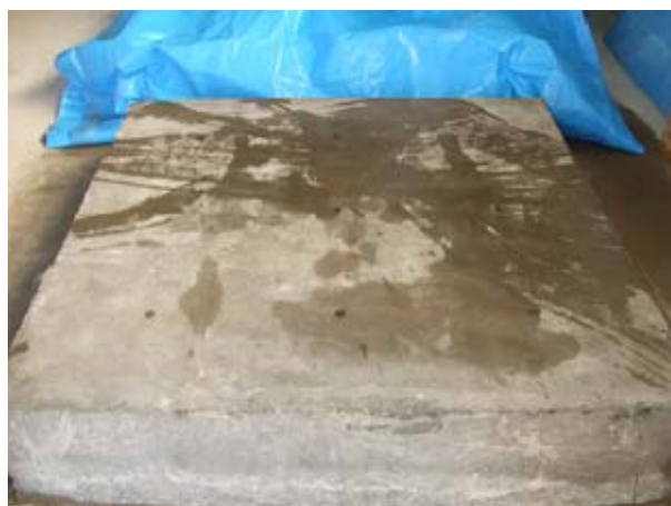
写真-1 周辺コンクリート硬化後
