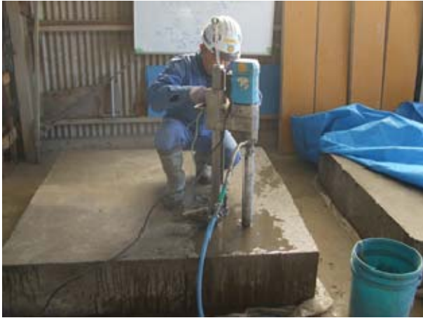
写真-2 コア抜き状況
