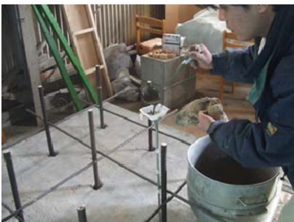
写真-8 グラウト注入の様子
