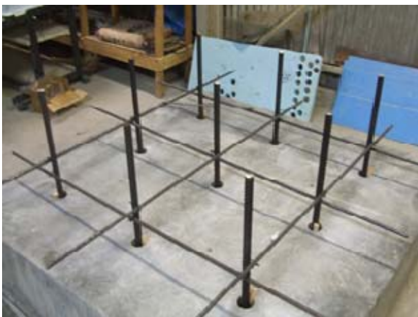
写真-7 補助筋配置
