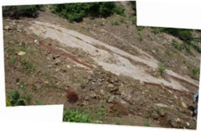
写真-2 露出したシルト質基岩
