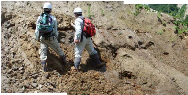
写真-3 斜面中腹で横断方向に延びる弱層
