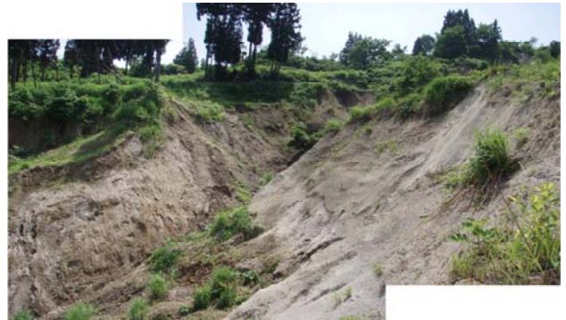
写真-4 斜面上部の侵食谷の状況（2006 年 6 月）
