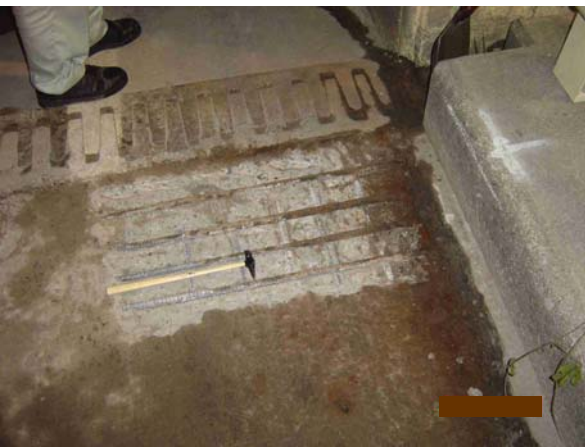
図-39 伸縮装置と地覆の角部における鉄筋腐食
