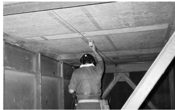
図-4 RC床版下面の含水率測定状況
