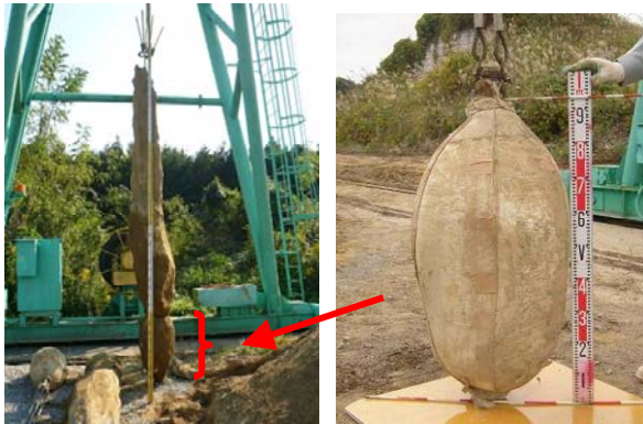
図20 アンカーの出来形（左：アンカー体、右：耐荷体）
