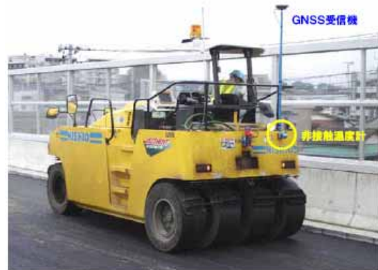
図-6 面的な舗装管理技術（温度管理）
