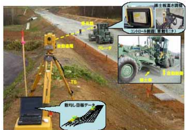
写真-1 グレーダ(マシンガイダンス技術)
