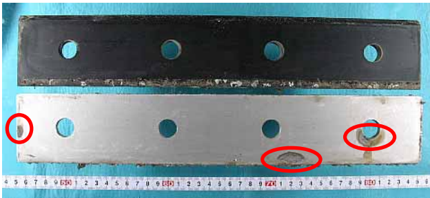
写真 - 9 水密ゴム押さえ板の腐食例 (SUS316-No3, 上は水密ゴム)
