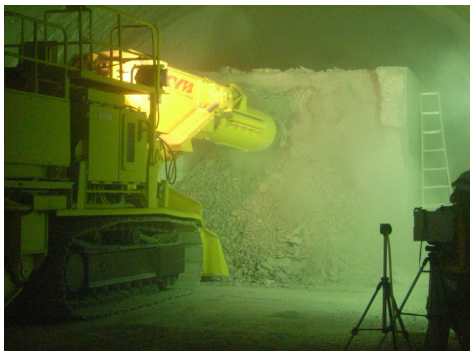
写真3 模擬岩盤コンクリート掘削状況
