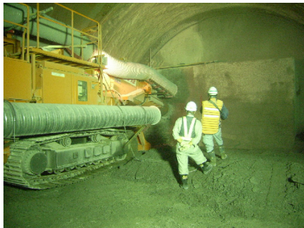
写真5 実験状況(局所集じんシステム)
