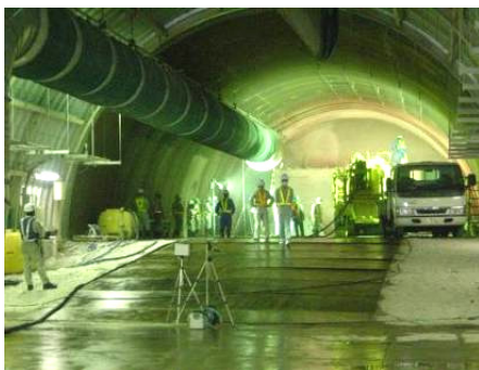
写真6 実験状況(伸縮風管システム)
