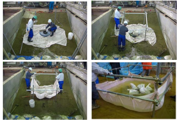
写真-2 省力化釜段・月の輪工
