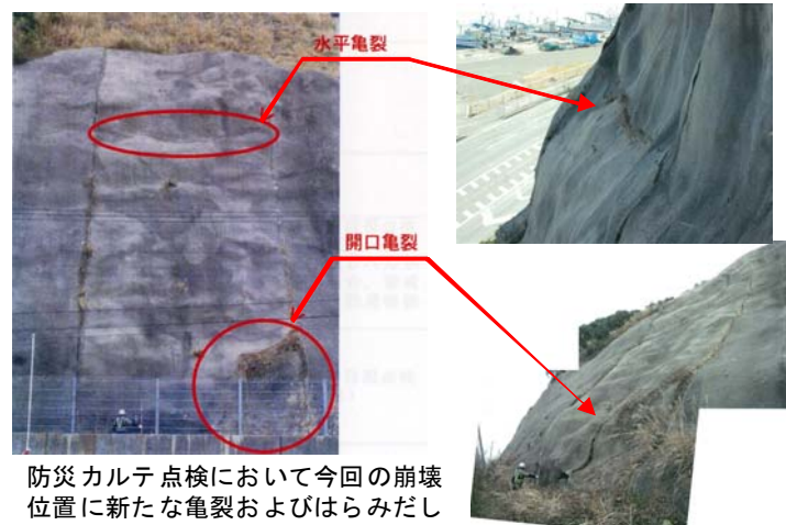
図-12 岩盤崩壊の災害事例
