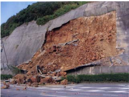
図-11 落石の災害事例
