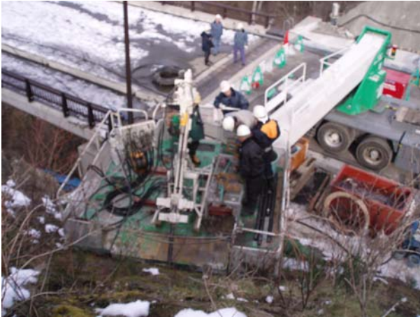
図-5 作業デッキ上での岩盤斜面掘削の様子
