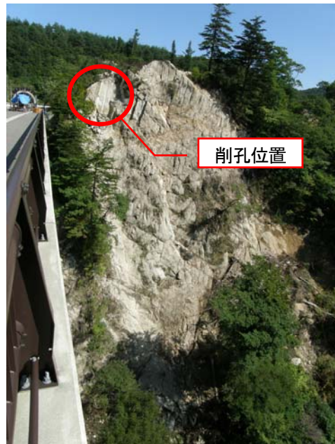
図-3 調査対象岩盤斜面の状況
