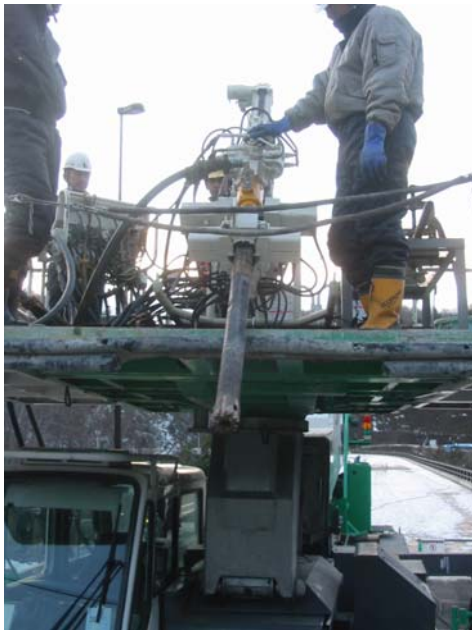
図-2 掘削ドリルの作業デッキへの取り付け状況
