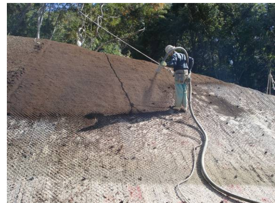
写真-4. 施工時の状況
