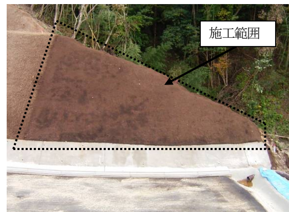
写真-5. 施工完了時の状況
