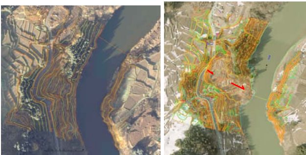
図-9 地すべり災害前後のオルソデータ(左:災害前、右:災害後)
