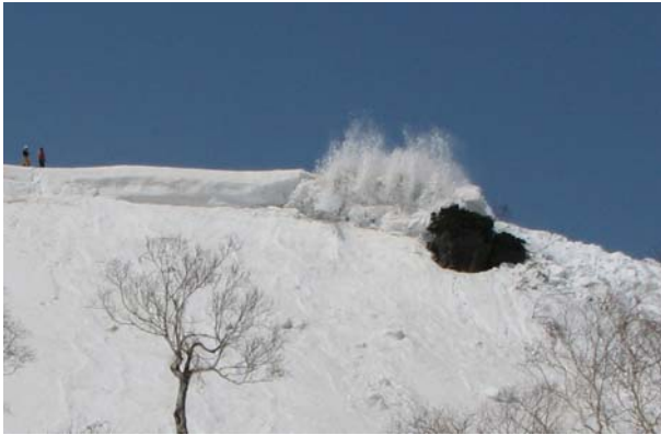
図 6 蒸気圧破碎薬剤を用いた雪庇処理事例
